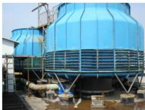
(改造前的冷却塔)
