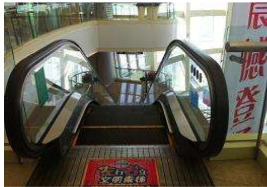
图为电梯感应变频节能改造
