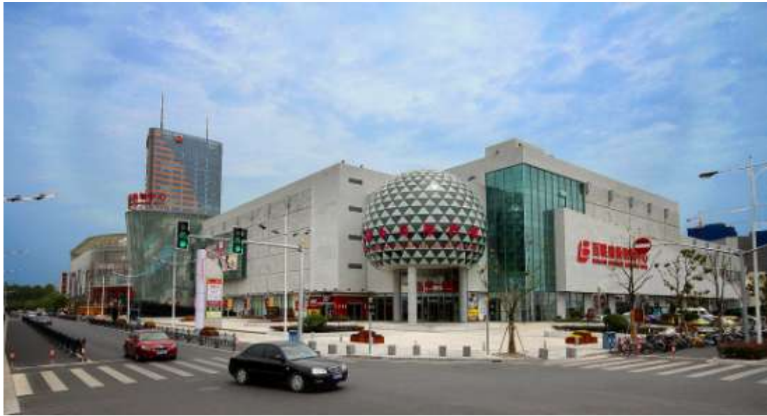
图为百联南桥购物中心二期南面外景
