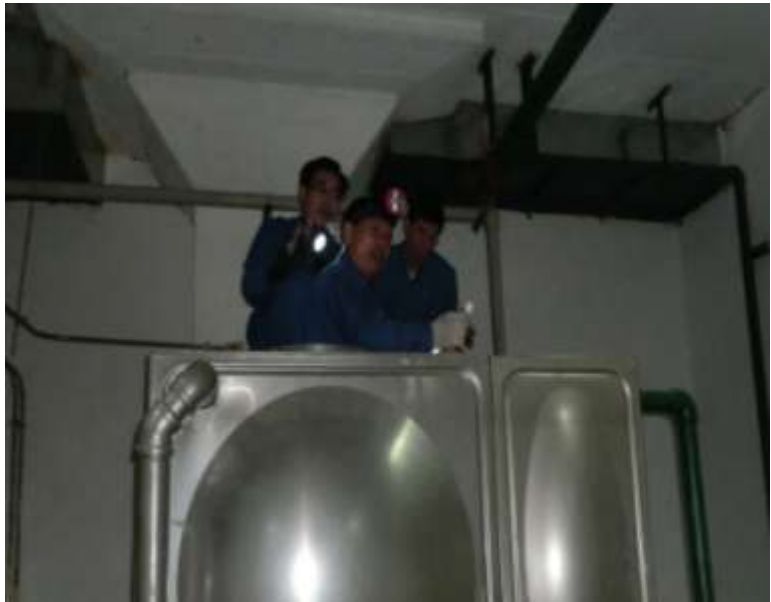
（图为：维修人员正在进行水箱修复）
